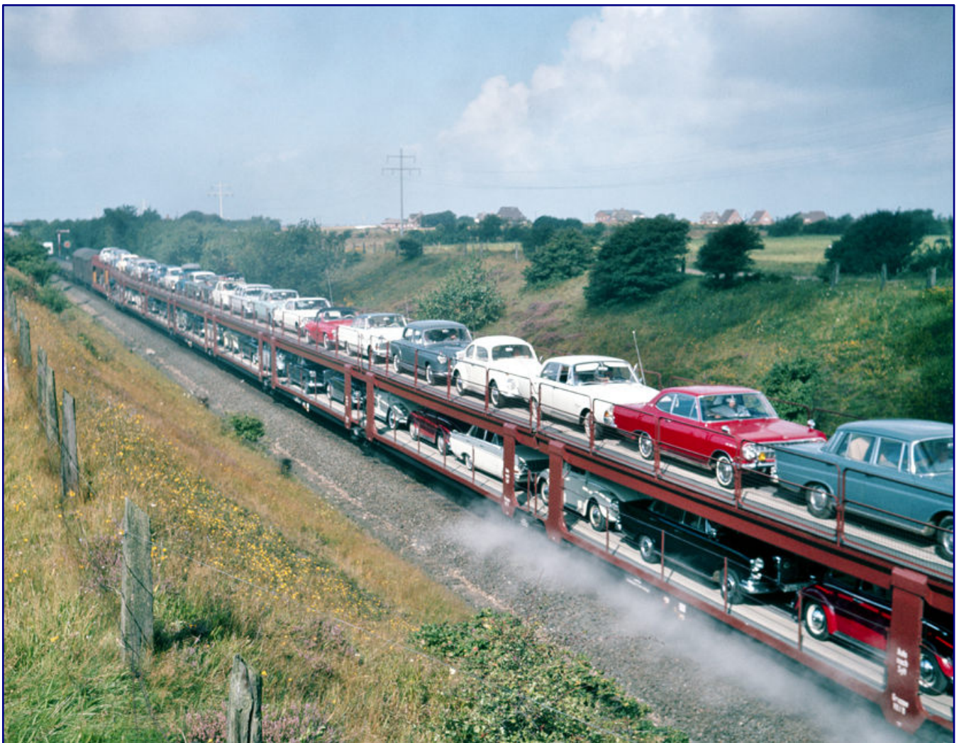
Ein kurzer Blick auf den Autotransport nach Westerland im August 1969 bei Morsum: Eine neunteilige „Westerland-Einheit“ besteht aus zwei Endwagen, die dem Laes 547 entsprechen, sowie sieben Mittelwagen. Sie setzen die zuvor eingesetzten, zweiteiligen Laes 543 frei. Foto: Reinhold Palm, Sammlung Eisenbahnstiftung
